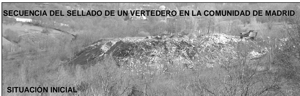
Fotografía 11. Se observan montones de RCD y las pendientes inestables de los taludes
