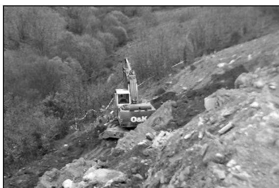
Fotografía 6. Giratoria desmonta un talud
