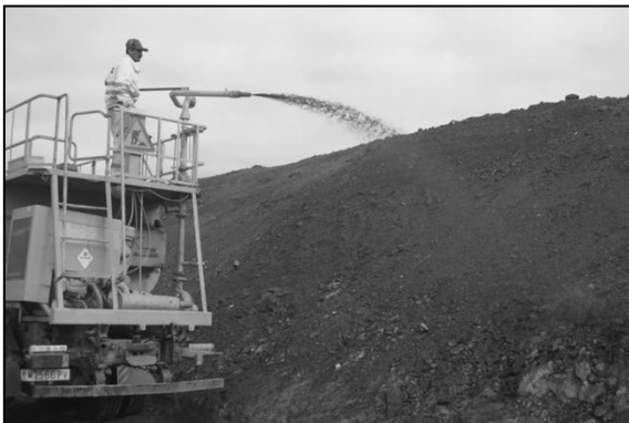
Fotografía 8. Ejecución de hidrosiembra en talud
