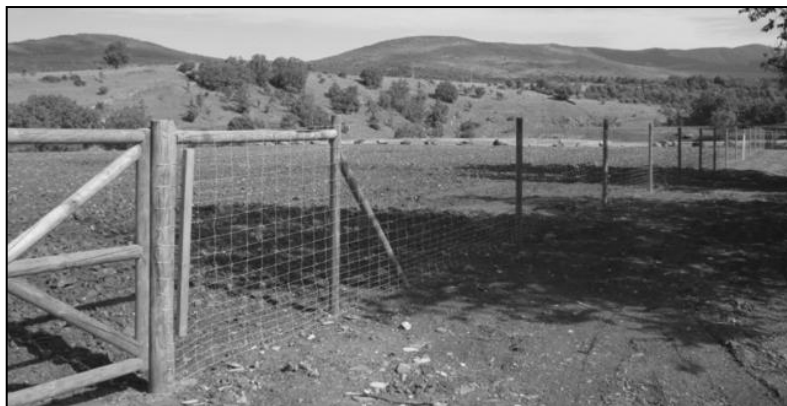
Fotografía 10. Cerramiento perimetral en vertedero sellado, mediante postes de madera y malla cinética
