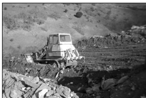
Fotografía 7. Bulldozer extiende material para poder suavizar la pendiente
