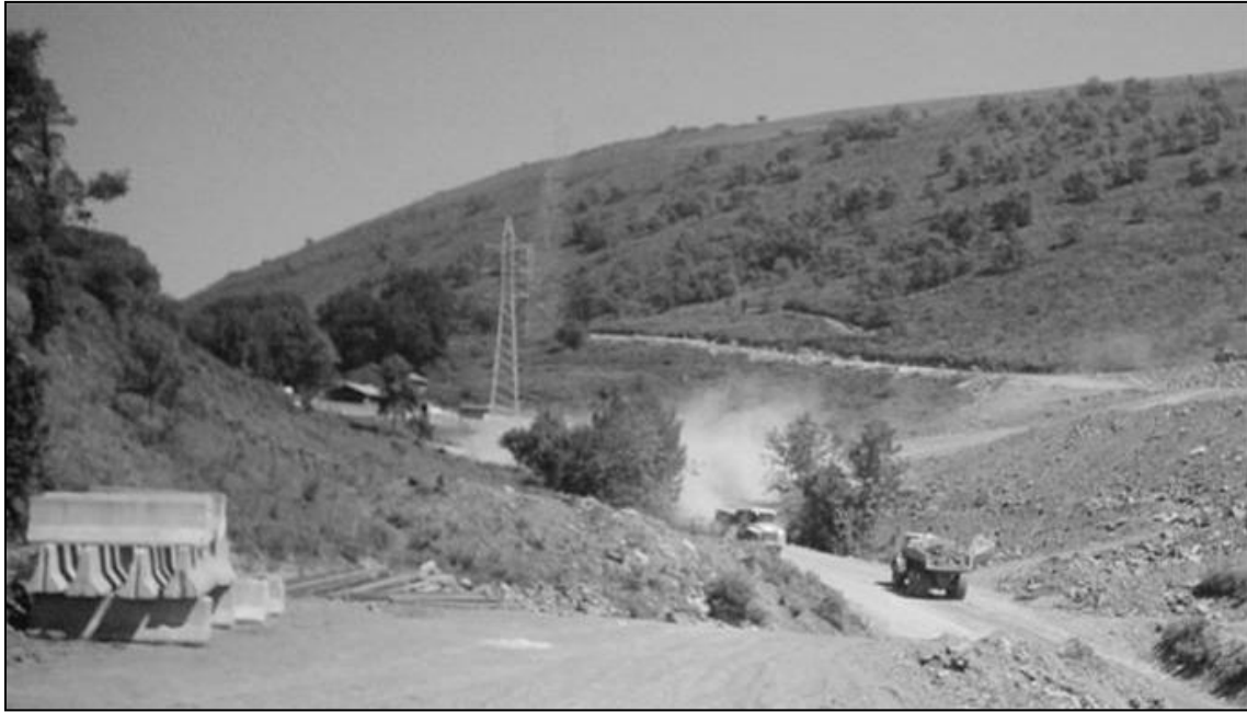
Fotografía 1. La formación de polvo como consecuencia del tránsito de maquinaria pesada es uno de los aspectos comunes de control en obra
